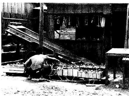
Het gemeentelijk energiebedrijf te Sisophon.
